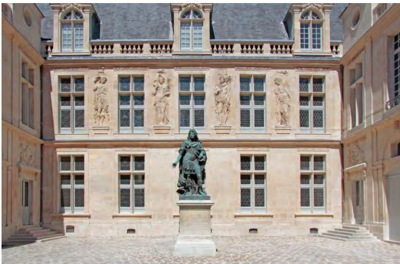
La cour d'honneur de l'hôtel Carnavalet a déjà fait l'objet d'une rénovation et a été inaugurée en septembre 2015
